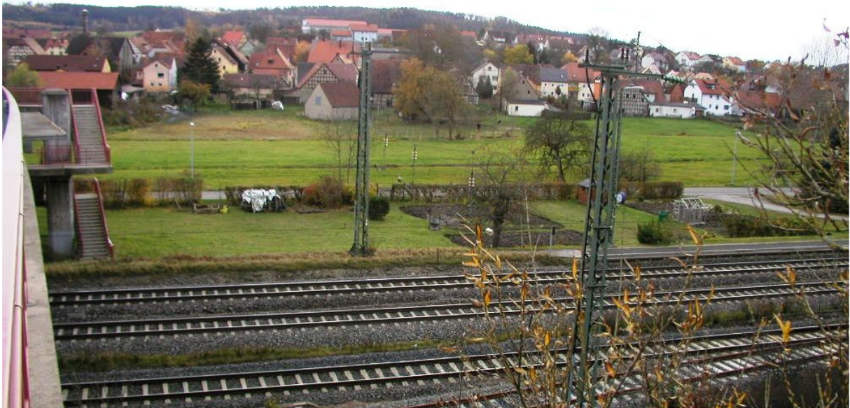
Foto 4: Wohnhäuser in der Hauptstraße, von der Straßenbrücke der St 2245 aus fotografiert
