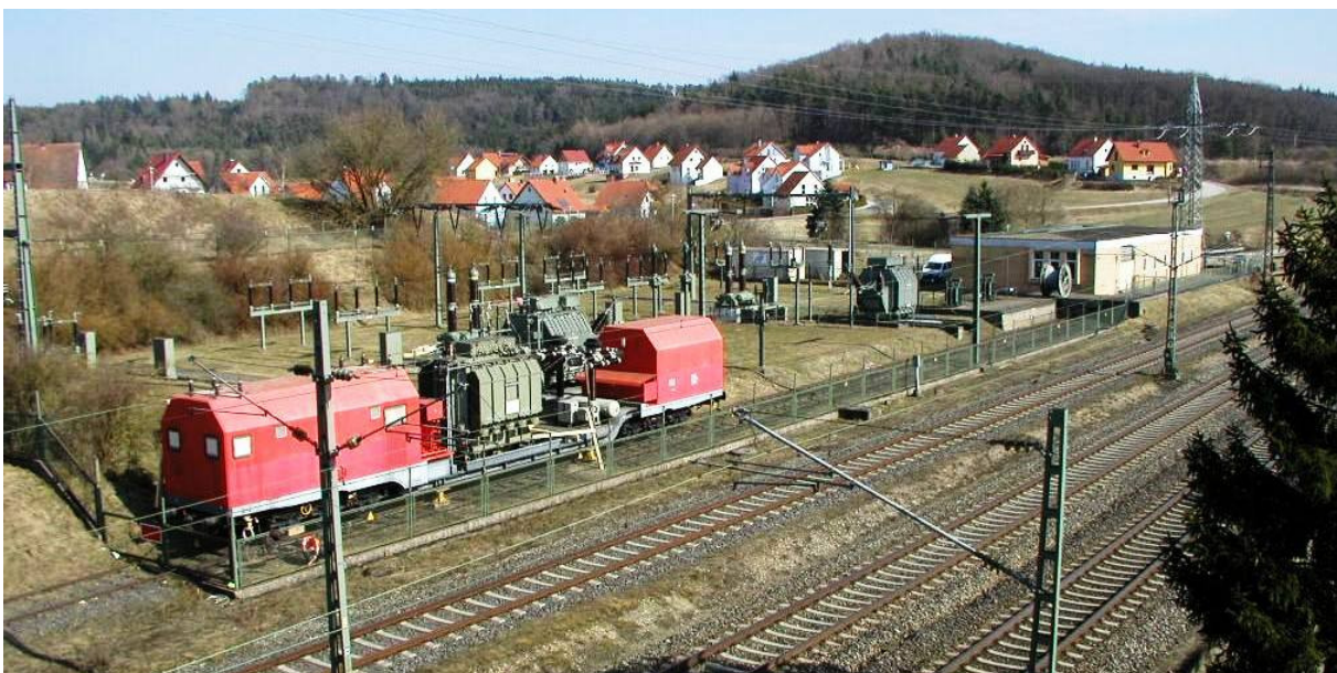
Foto 7: Wohnhäuser im Bereich des Bebauungsplans Birkenbachtal, im Vordergrund das DB-Umspannwerk
